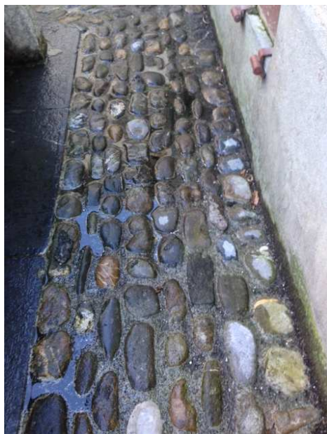
Figure 3: Exemple d'aménagement réalisé avec des galets de rivière sur un lit de béton.
