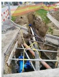
Nous avons profité de l'installation de la nouvelle BH à proximité de Fenaco (Landi) pour réaliser le bouclage avec le TCS, Fenaco et la Commune. De ce fait, une nouvelle conduite a été installée le long de la route de La Sarraz.
