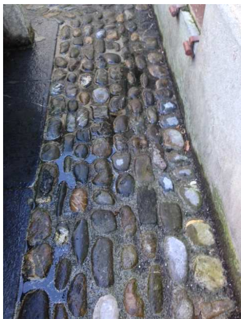
Exemple d'aménagement réalisé avec des galets de rivière sur un lit de béton. Plan type de pavage en grès.
