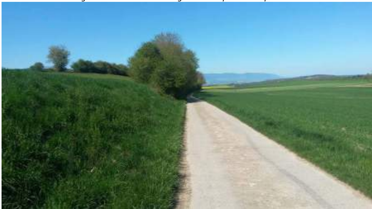
Figure 6 : Vue de la zone de glissement spontané depuis le sud
