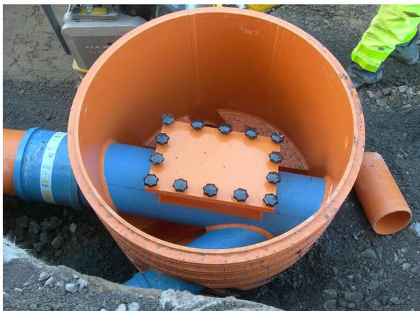
En raison de l'avancement des constructions du quartier de Sécheron, les travaux relatifs à la réfection et au réaménagement de la rue des Terreaux ont débuté à l'automne 2010 et se sont déroulés à un rythme élevé. S'agissant des chambres du réseau d'égouts EU + EC, la Municipalité a choisi une solution innovante proposée par l'entreprise de génie civil. Il s'agit d'une chambre mixte qui autorise de diminuer la largeur de la fouille par rapport au système traditionnel,
