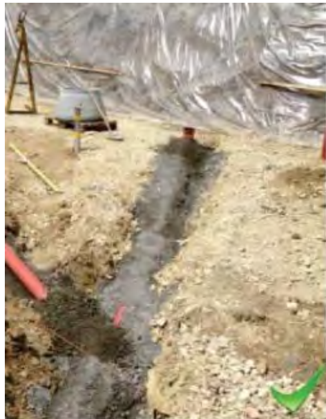
Canalisation en cours de bétonnage
