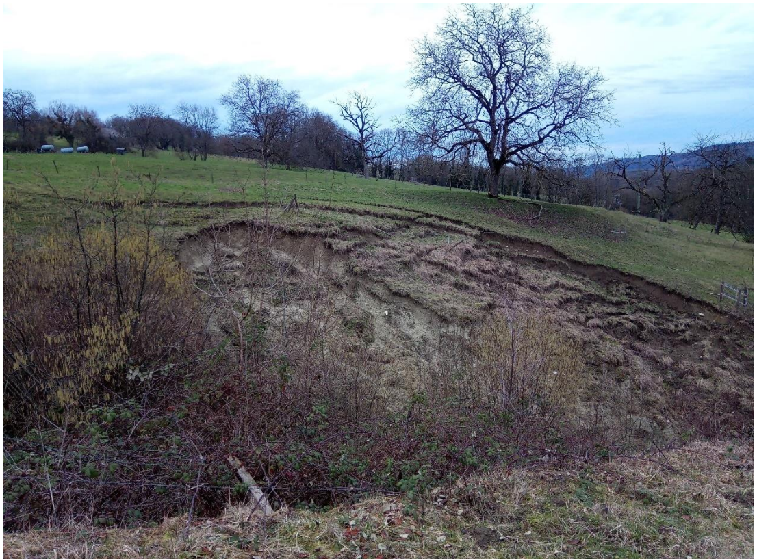
Figure 18 : Exemple d'érosion de berges actif en rive gauche. Des phénomènes similaires se produisent cependant également en rive droite.
