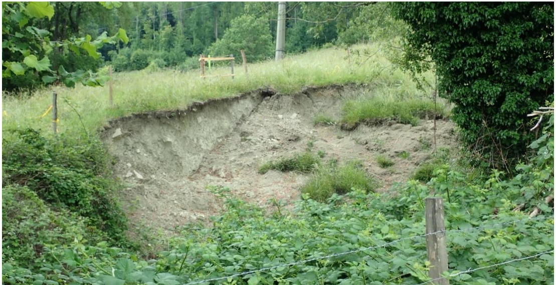
Figure 2 : Exemple d'érosion latérale (rive droite) le long du ruisseau des Rochettes.
