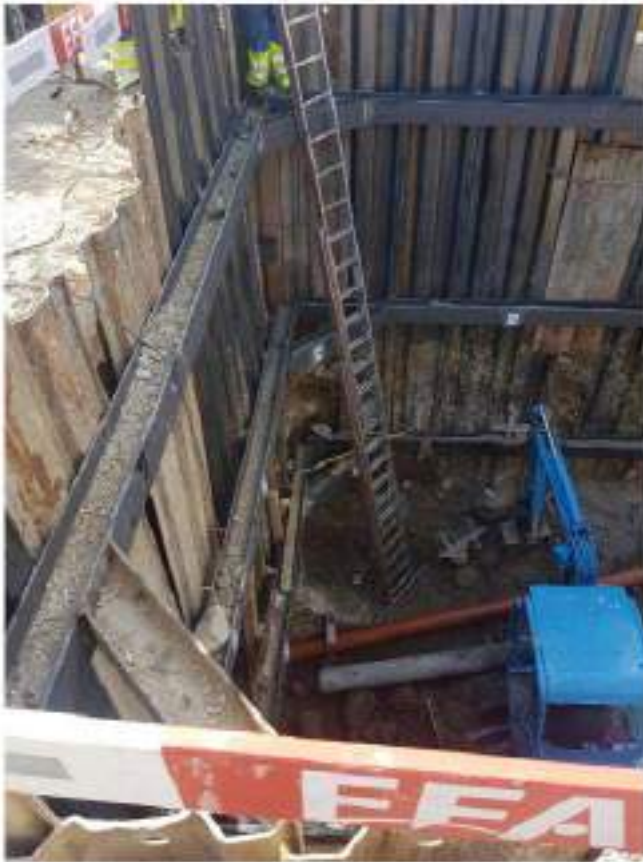
Fouille blindée place de la Tannaz – vue sur galerie existante
