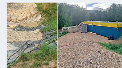
Chantier du ruisseau des Rochettes.
