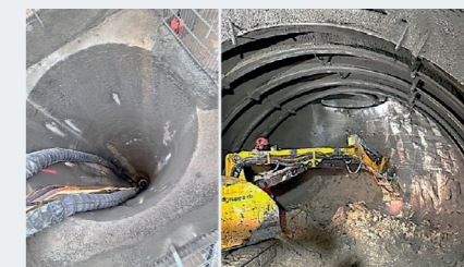
Travaux du Vortex.
