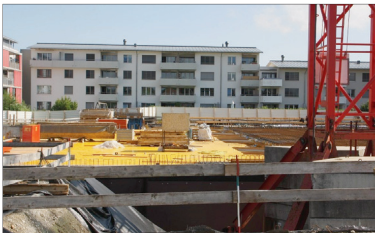
Les murs vont bientôt «sortir» de terre.
