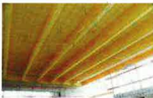
Longues poutres transversales.
