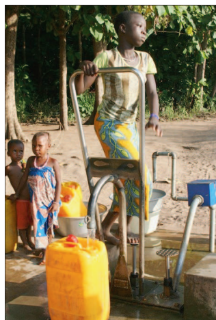
Installation de pompage et aduction d'eau toute récente.
