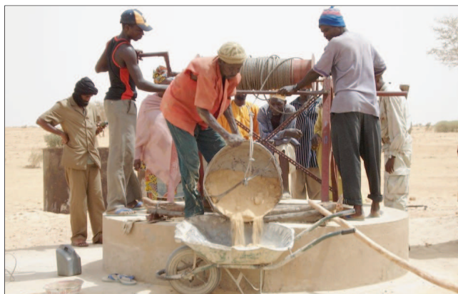
Création d'un puits pour faciliter l'approvisionnement.
