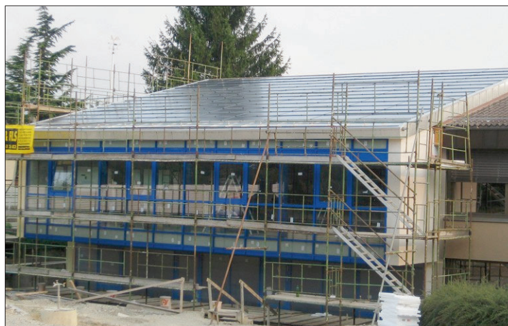
Le toit du PAM, lors de la construction.
